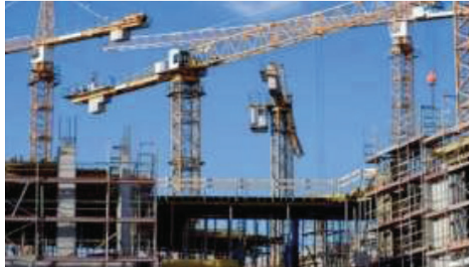
Görsel 3.34: Kaldırma aracı-kule vinç
