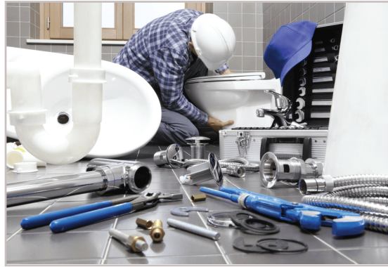
Görsel 3.44: Sıhhi tesisatta çalışma
